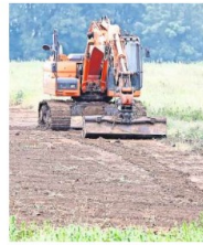
Die Stadt lässt derzeit die Suchschnitte der Voruntersuchungen verschließen. FOTOS (3): WERNER KAISER
